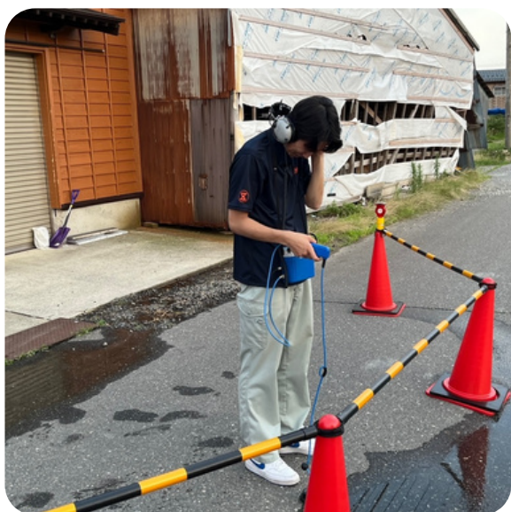
漏水調査の様子
