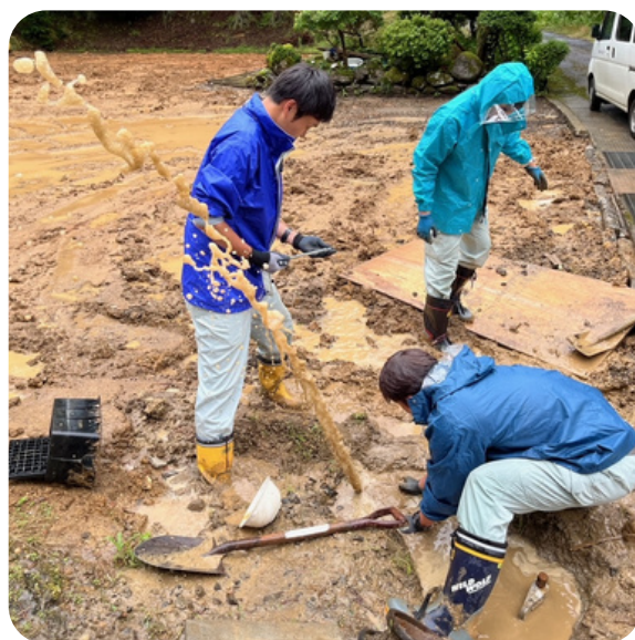
漏水修理の様子
