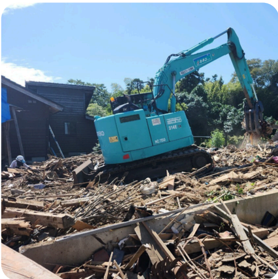
解体作業の様子
