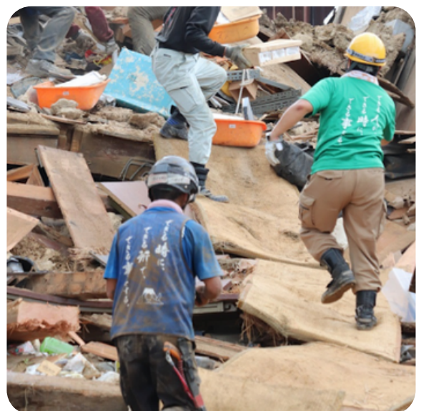
公費解体を行う家屋から貴重品を 搬出する作業の様子
