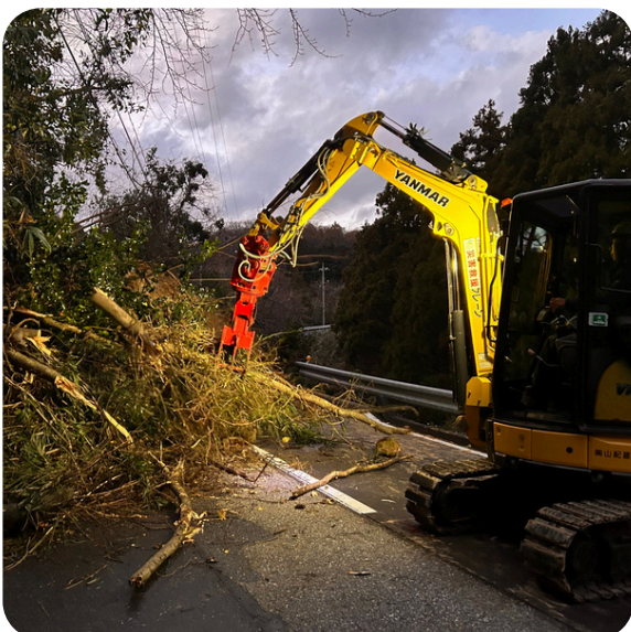
道路啓開の様子
