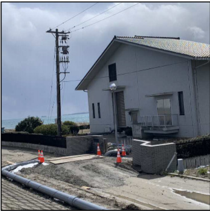
図-1 仮管布設状況(熊谷汚水中継ポンプ場)
