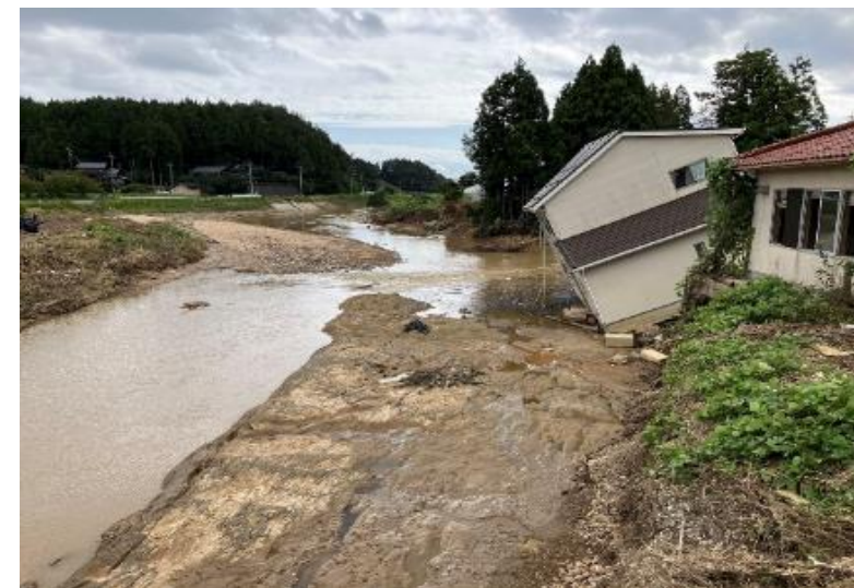
若山川(若山町)の被災状況
