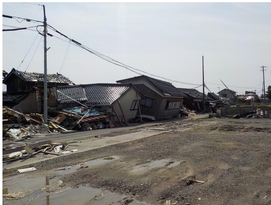
公費解体前(令和6年4月7日時点)
