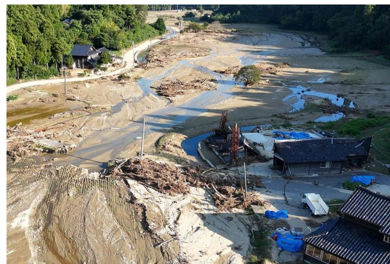
竹中川の被災状況
