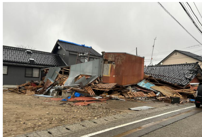
珠州市内家屋倒壊状況(令和6年2月5日撮影)
