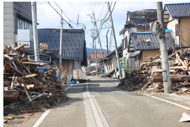
珠州市内家屋倒壊状況(令和6年2月12日撮影)
