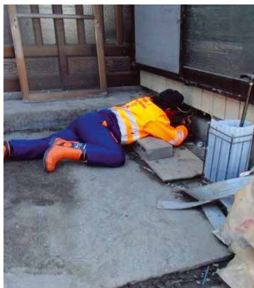
通風口から床下の泥を確認する
