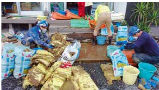
↑断熱材の取出し
