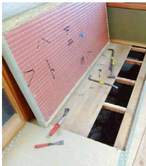
和室の床板をはがす（写真①）
