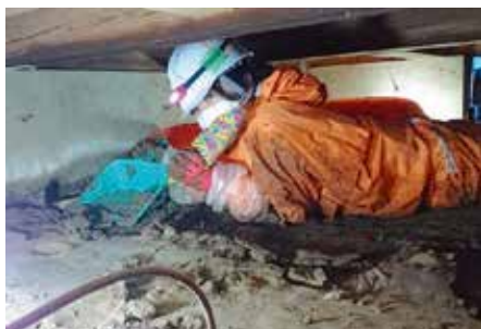
床下の泥だしの様子
