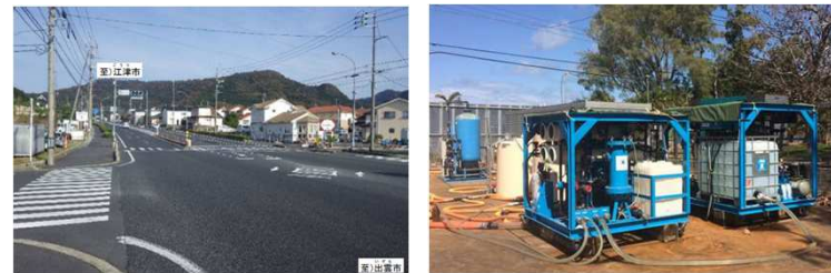
1-4 無電柱化等による道路の強靱化、可搬式浄水施設
