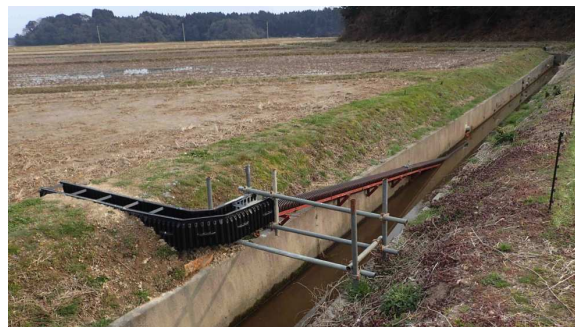
トキのエサとなるドジョウのために水田に取り付けた魚道(粟津地区)
