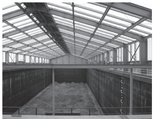
富山県黒部市にある宮沢清掃センター最終処分場
