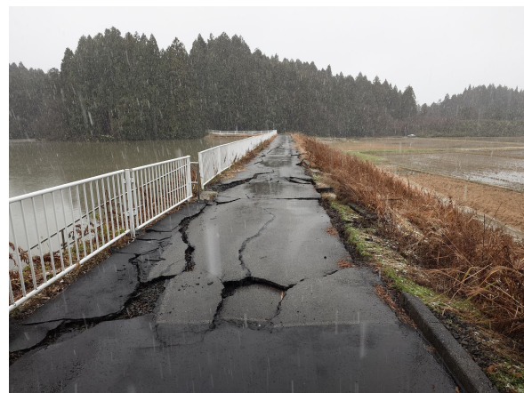
ため池堤体の被災状況
