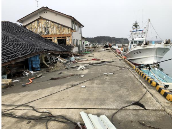
隆起したマンホール
