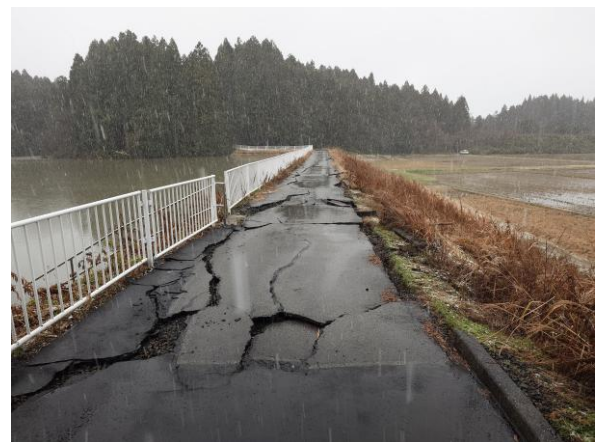
ため池堤体の被災状況
