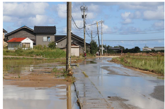
上戸地区の豪雨における被害の様子
