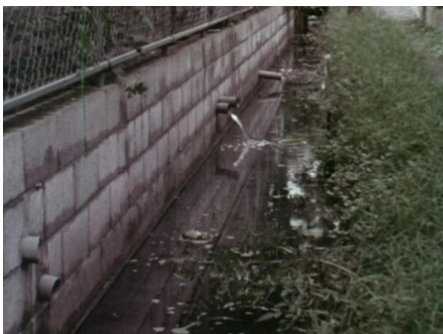
(下水道整備前)
