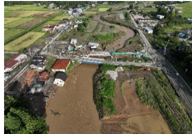
珠洲市若山町 奥能登豪雨による被害状況 ※2
